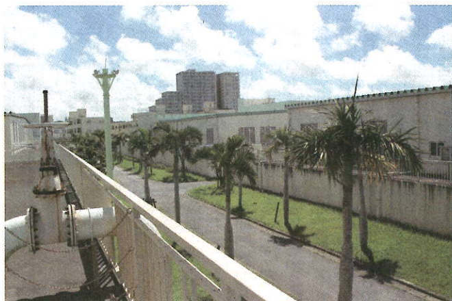
更新事業により水処理施設の覆盖化が実現した北谷浄水場
